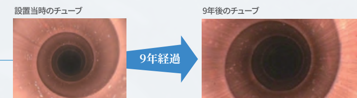
新設熱源機導入から9年経過後も変わらず良好なチューブ環境を維持
